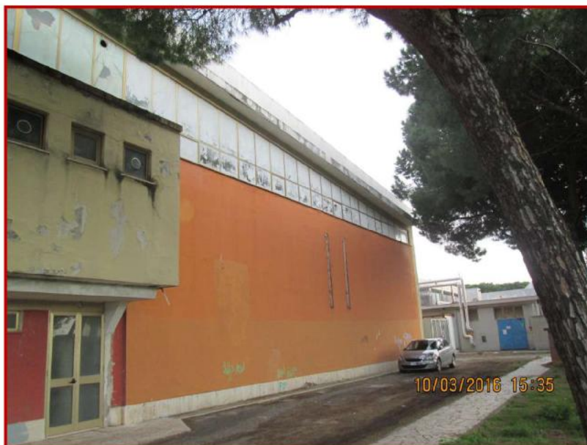
Foto 2: prospetto ovest PalaCosmelli
