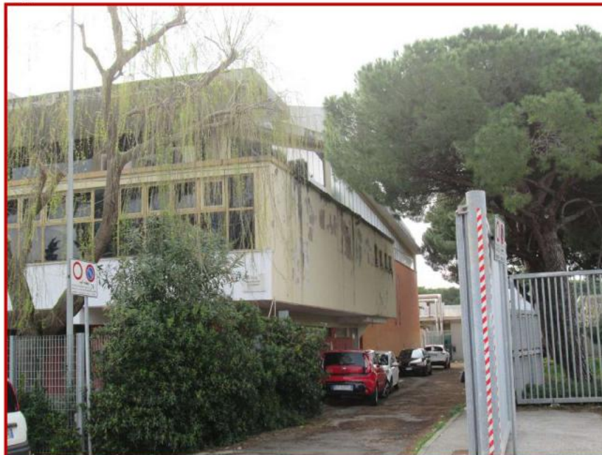
Foto 1: prospetto ovest PalaCosmelli
