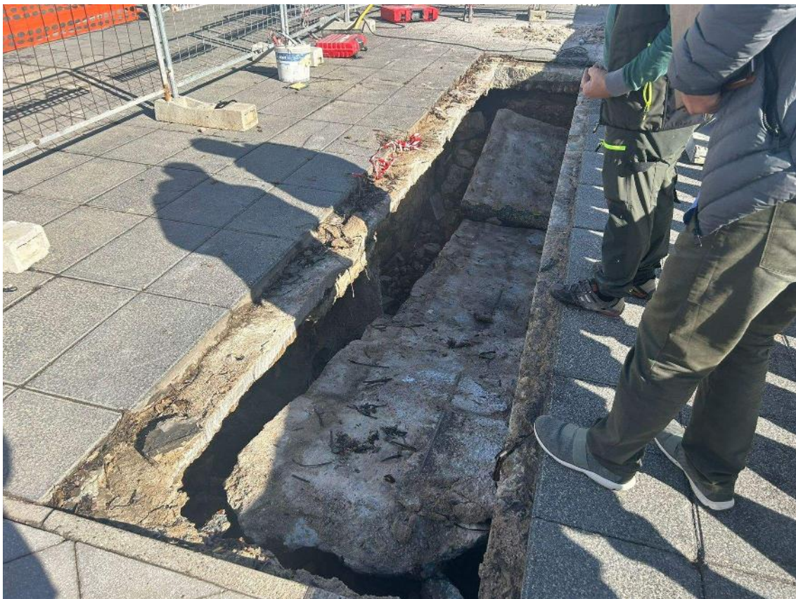
Pavimentazione in cemento sopra il Fosso dei Cavalleggeri
